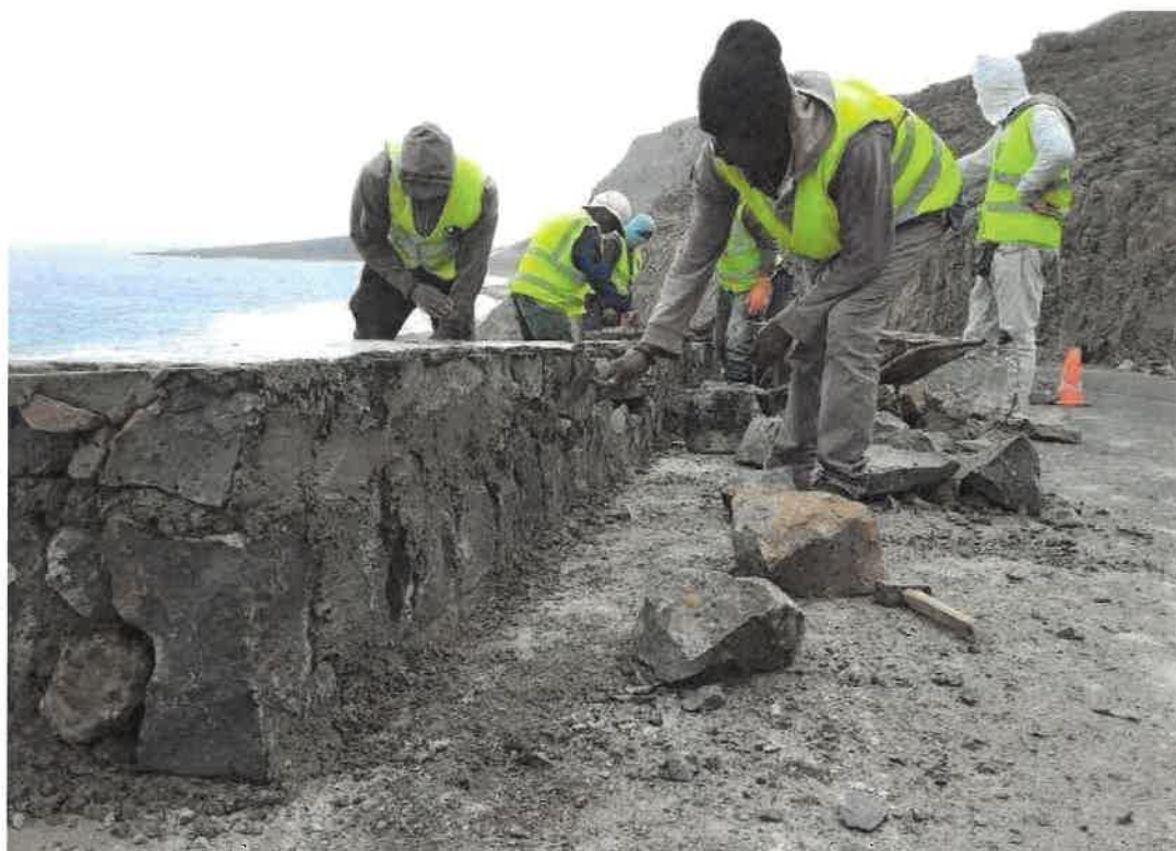
Figura 15 - Substituição de guardas metálicas por muro cortina - Estrada Baía / Calhau – São Vicente
