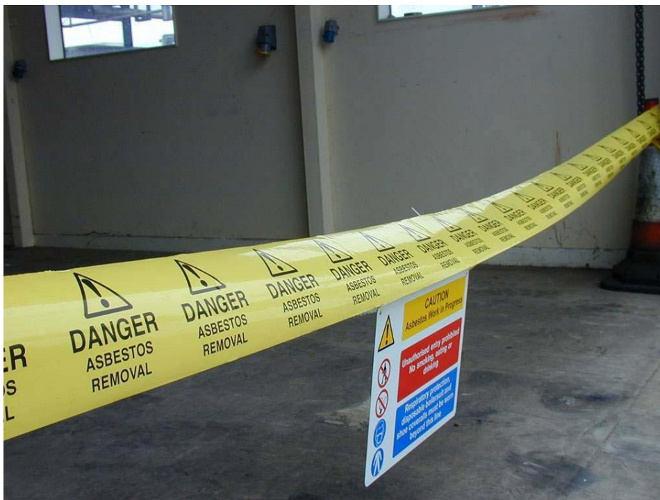
Figura 8. Utilização de fita (com a menção «Perigo Remoção de Amianto») e sinais de aviso para delimitar a zona
