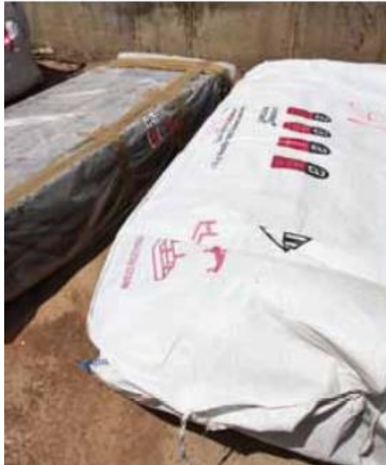
Figura 17. Resíduos da demolição acondicionados
