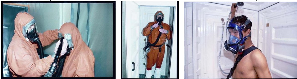
Figura 15. Descontaminação com aspirador de tipo H, no chuveiro com fatos-macaco impermeáveis e banho de chuveiro antes da remoção do equipamento de proteção respiratória
