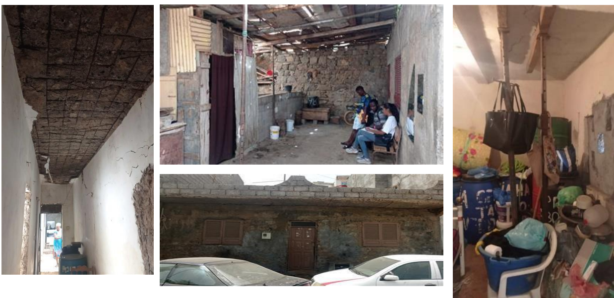
Figura 5. Habitações elegíveis à reabilitação no âmbito do PRH no Bairro de Safende
