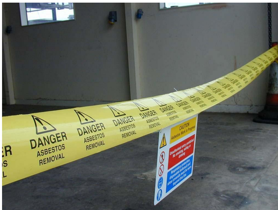
Figura 8. Utilização de fita (com a menção «Perigo Remoção de Amianto») e sinais de aviso para delimitar a zona
