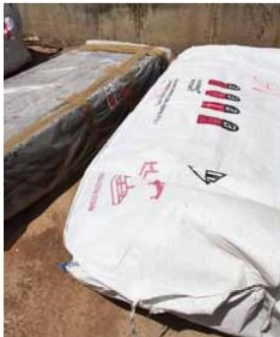
Figura 17. Resíduos da demolição acondicionados
