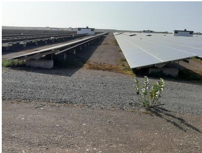
Foto 1 - Painéis solares fotovoltaicos e estrutura de suporte assentes em blocos de betão (Ilha do Sal)
